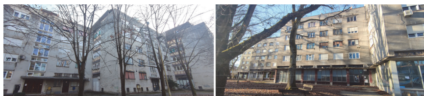
Slika 2. Pročelja bloka zgrada
