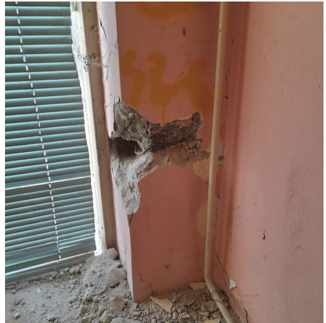
Slika 5. Istražna sonda stupa prizemlja
